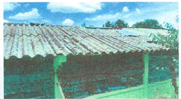
Foto 4: Sustitución de lámina
