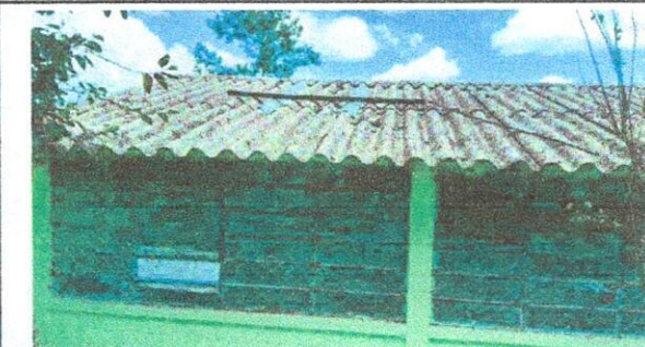
Foto 6: Sustitución de lámina
